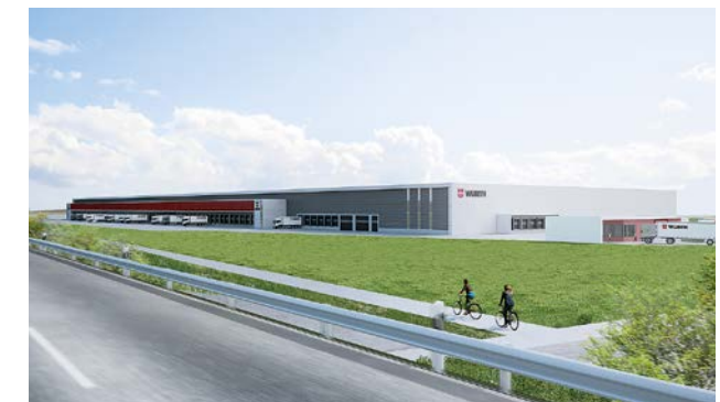
Im Bau: neues Umschlaglager der Adolf Würth GmbH & Co. KG direkt an der A 6
