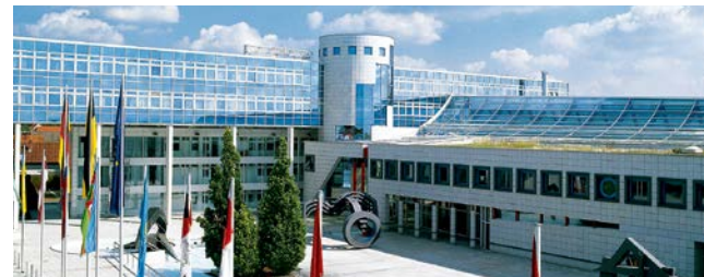
Würth Verwaltungsbau in Künzelsau
