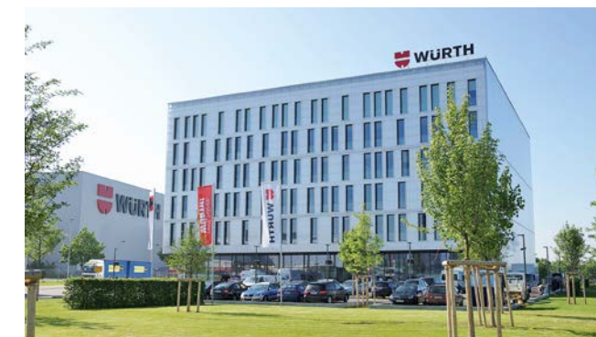
Neues Niederlassungs- und Verwaltungsgebäude der Adolf Würth GmbH & Co. KG in Künzelsau-Gaisbach
