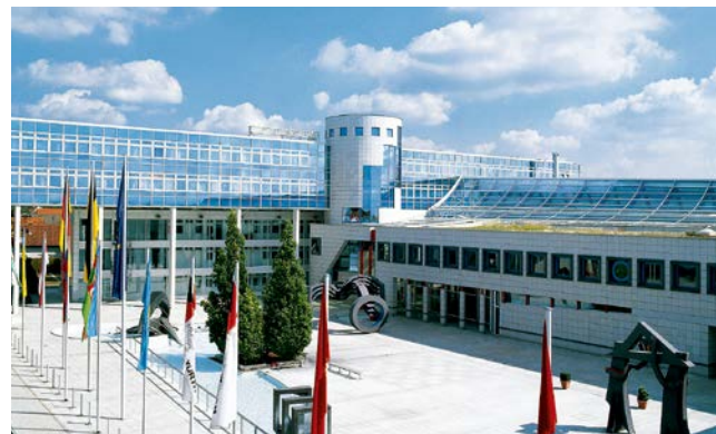
Würth Verwaltungsgebäude in Künzelsau-Gaisbach
