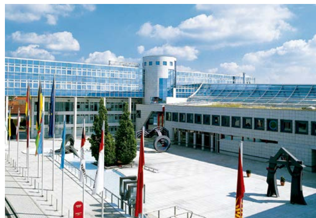
Würth Verwaltungsbau in Künzelsau-Gaisbach
